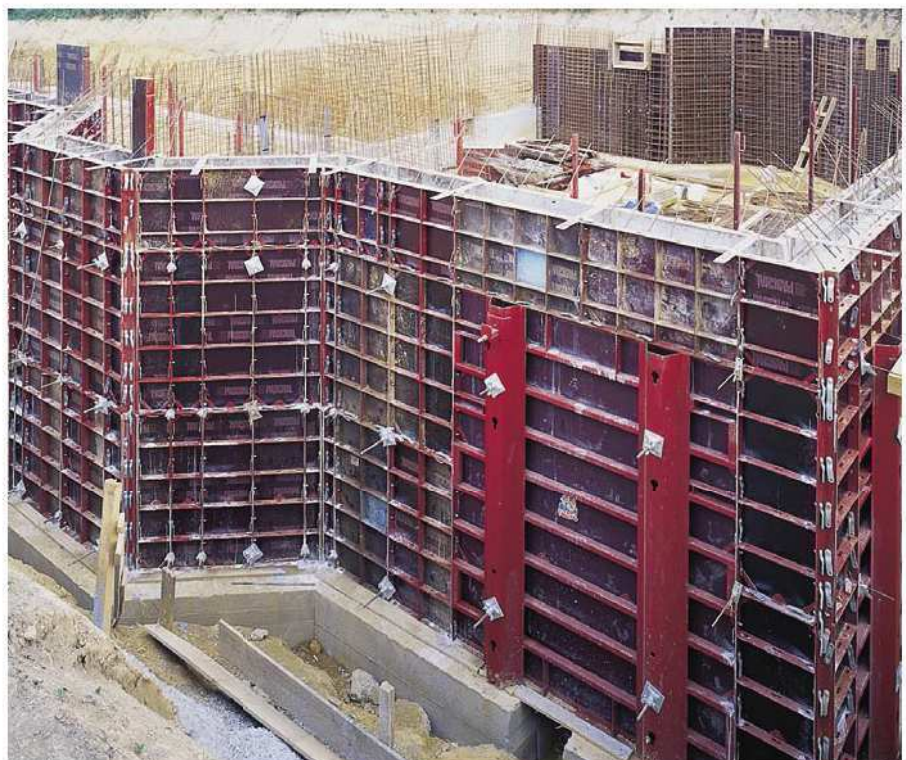
Wohnhaus, Jöbnitz; Fa. Vogtland Bau GmbH, Plauen
