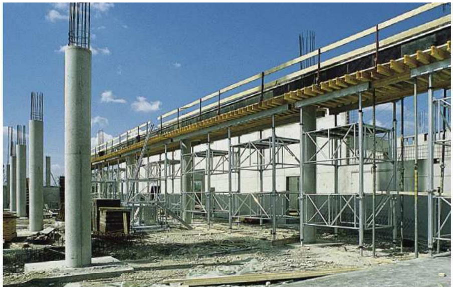
OBI-Baumarkt, Freiburg; Fa. Dyckerhoff & Widmann AG, Freiburg
