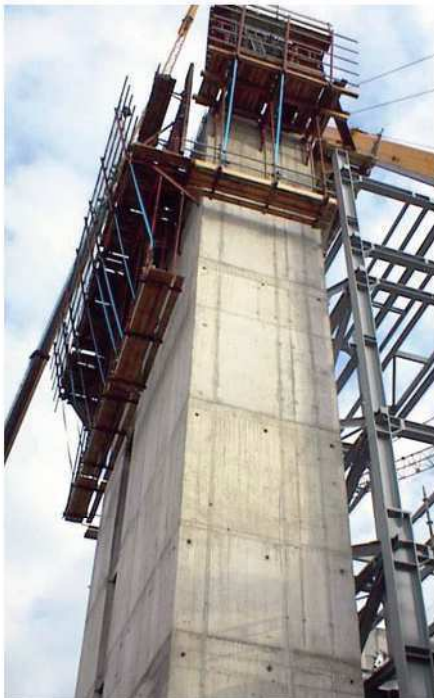
Treppenturm (mit Fahrstuhl), Heizkraftwerk Berlin-Neukölln; Fa. NCC Deutsche Bau GmbH, Fürstenwalde
