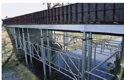
Brücke, Reichelsheim; Fa. Müller, Schotten
