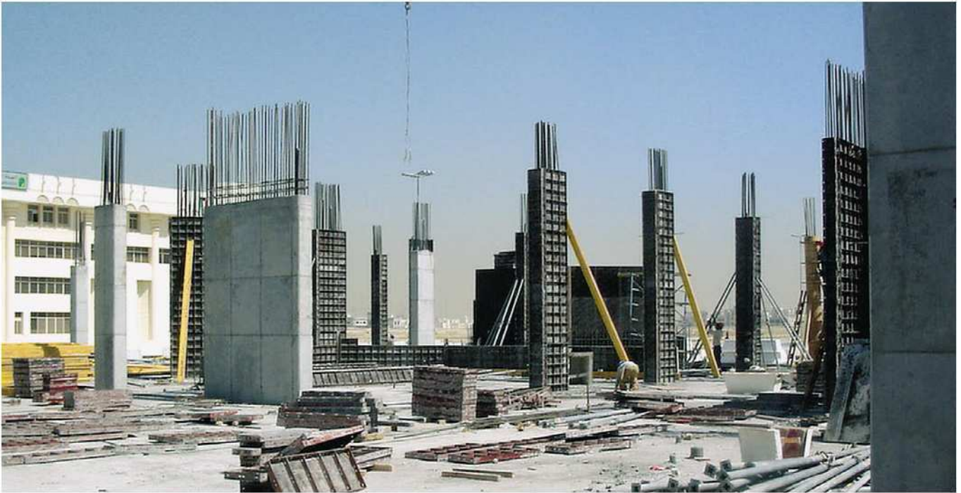
Zentrale der Industrie- und Handelskammer, KWT-Kuwait; Fa. Al-Bab Al-Kuwaiti Construction, KWT-Kuwait
