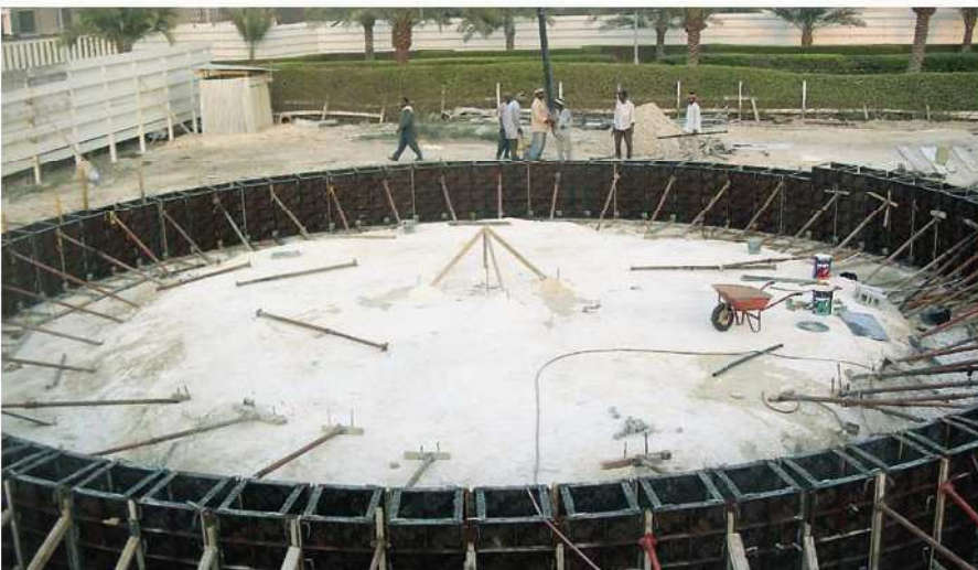
Fundament für Stahlbehälter, Flughafen BRN-Bahrain; Fa. R.P. Construction, BRN-Bahrain
