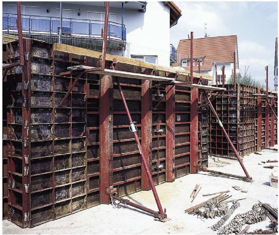
Wohn- und Geschäftshaus, Kesselsdorf; Fa. Häufele Bau GmbH, Dresden
