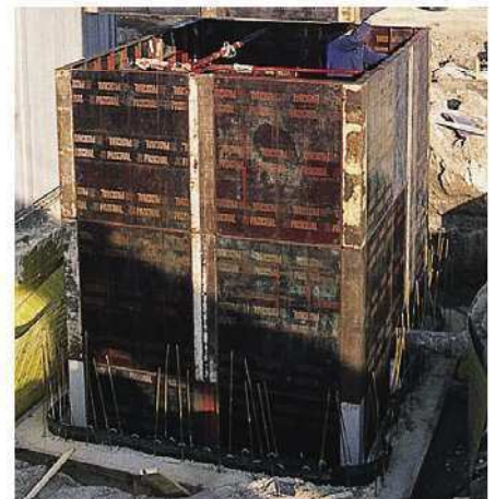
Kläranlage, Annaberg; Fa. Hofmann, Herzberg
