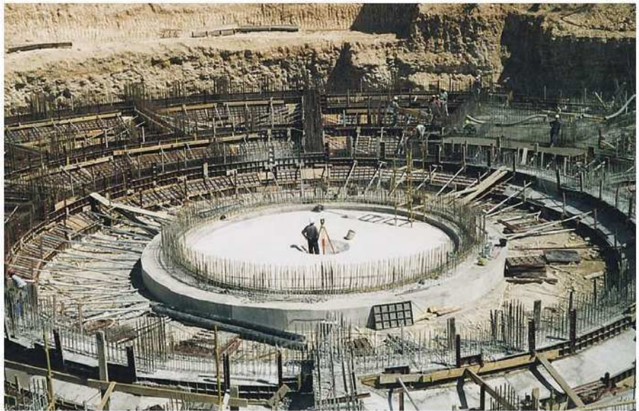
Verwaltungsgebäude Ersoc, DZ-Algerien; Fa. Travosider, DZ-Algerien
