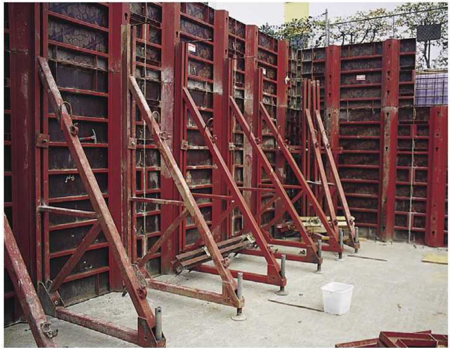
Einsatz des Eckgurtes bei 90°-Ecken
