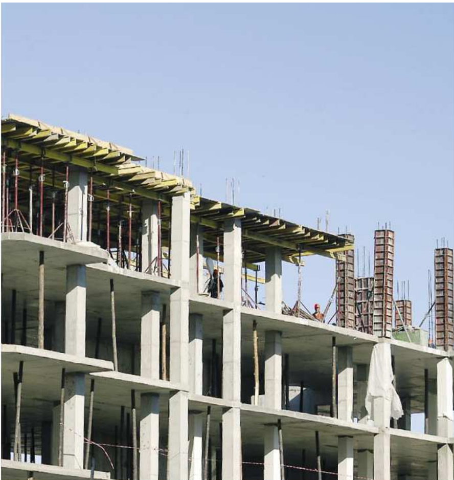
Mehrstöckiger Wohnblock, KZ-Astana; Fa. Ingenieursystem GmbH, KZ-Astana
